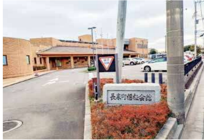
町の要請で災害ボランティアセンターが設置される福祉会館
