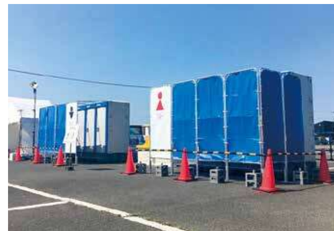
男女の区別がはっきり配慮された仮設トイレ
