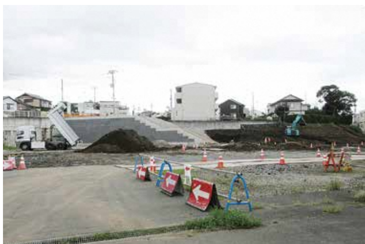
令和7年供用開始に向け整備が進む 鮎壺公園に9台の防犯カメラを設置予定
