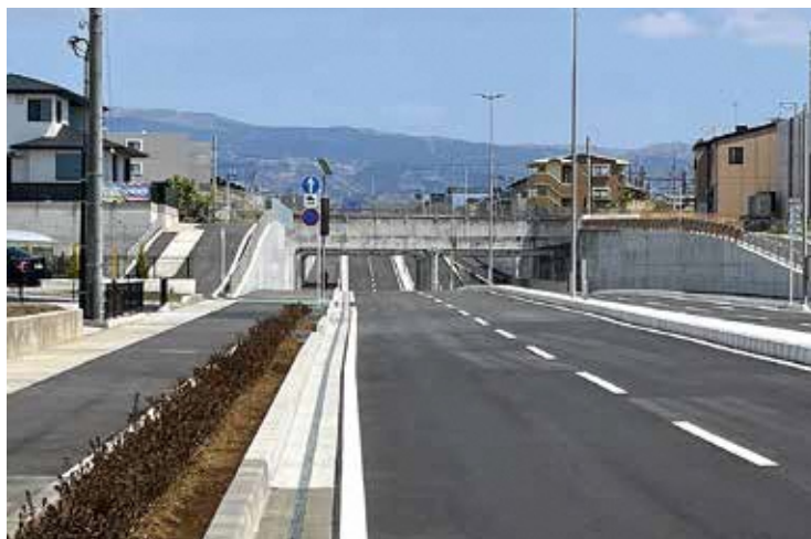
令和4年3月6日に一部開通した沼津三島線
