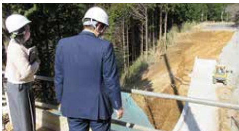
令和3年7月豪雨で崩落した町道425号線
