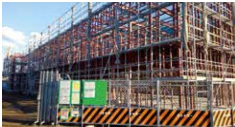
本校舎北側に建設中のプレハブ校舎
