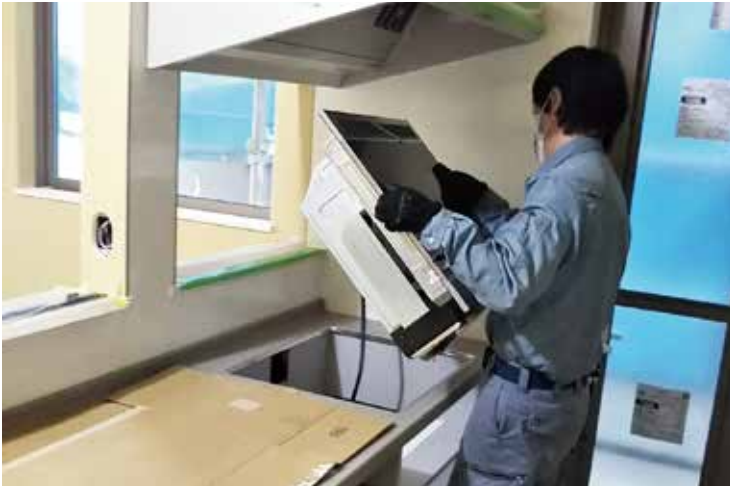
ただ今、キッチンの施工中
