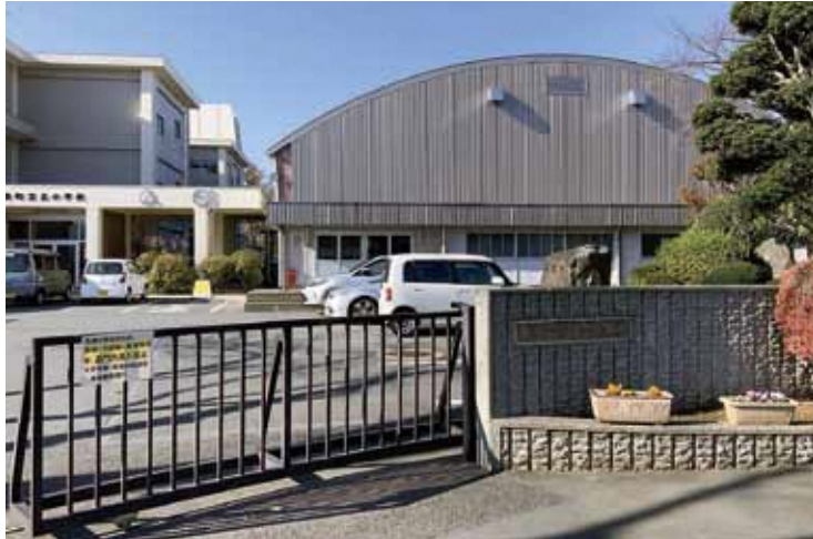
広域避難所の北小学校
