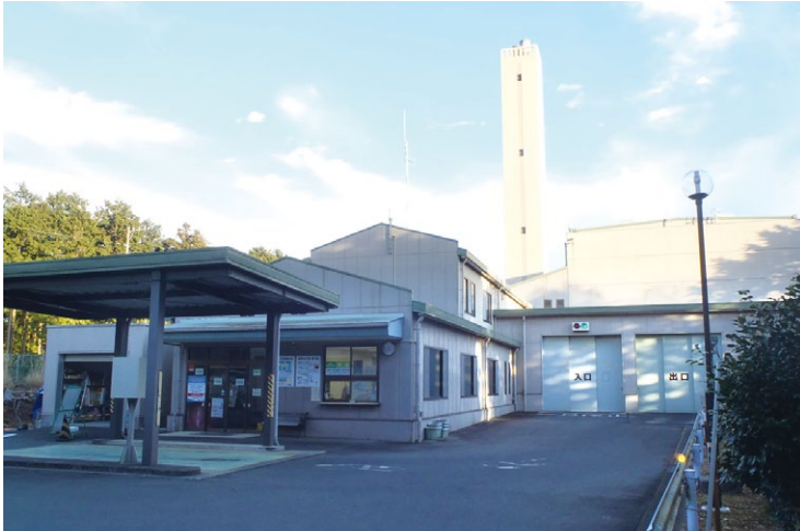
延命化をはかりながら使用している塵芥焼却場
