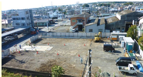
整備中の防災センター(仮称)
