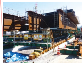
池田柵線の橋梁（整備中）
