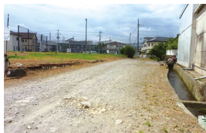
整備予定地(下土狩地先)
