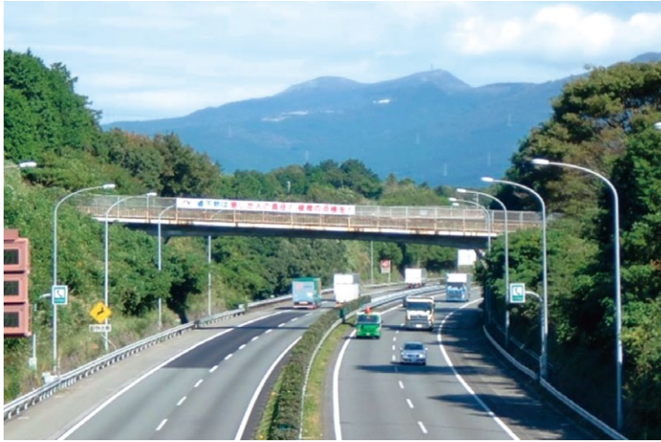
定期点検を実施
