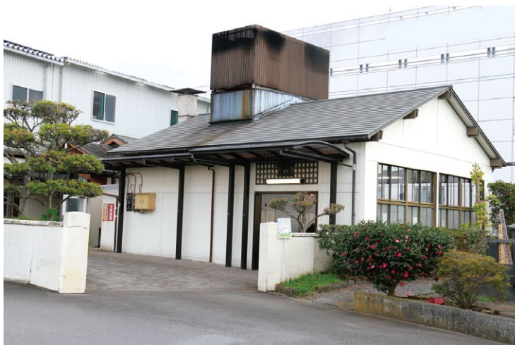
老朽化が進んだ火葬場
