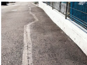
拡幅された道路（納米里地先）
