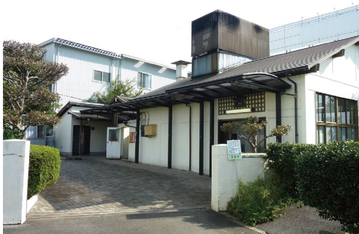
建設から 47 年が経過している火葬場
