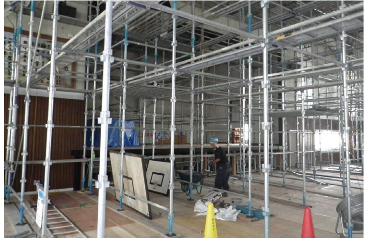
27年度に施工した長寿命化工事の状況 (北小学校体育館)
