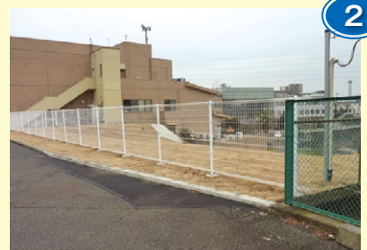
福祉会館周辺整備工事
