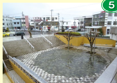
駅前広場改修工事
