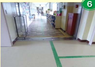
校舎内改修工事（長泉小）
