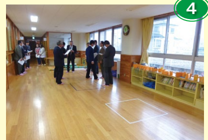
北幼稚園改修工事
