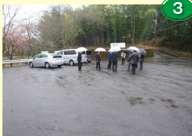
3 駿河平自然公園駐車場改修工事
