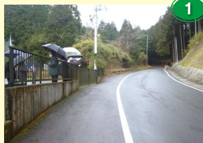
1 道路改良工事 (桃沢野外活動センター付近)
