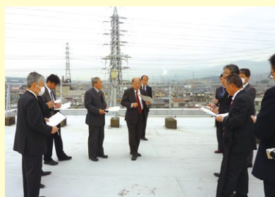
役場庁舎屋上防水工事 既存防水層を撤去し、新たに防水シートを設置する。
