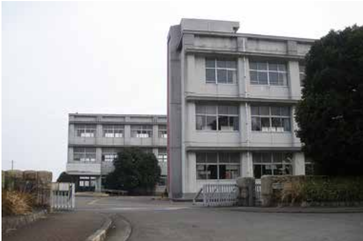
新拠点となる予定の長泉高校跡地
