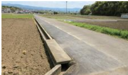
下長窪地内の農業用排水路工事
