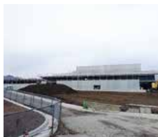
建設中の裾野長泉新火葬場
