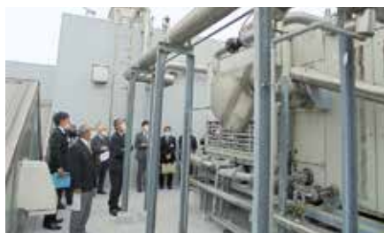
改修工事で環境整備を
