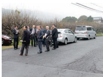
傷んだ町道の現地調査
