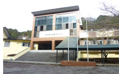
改修予定の野外活動センター
