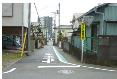
整備されたグリーンベルト
