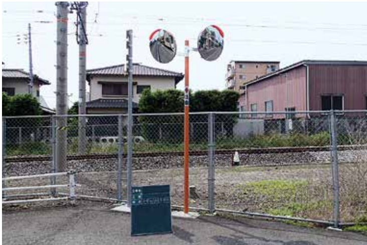
区からの要望で設置されたカーブミラー
