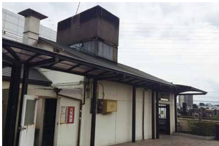
老朽化が進む火葬場
