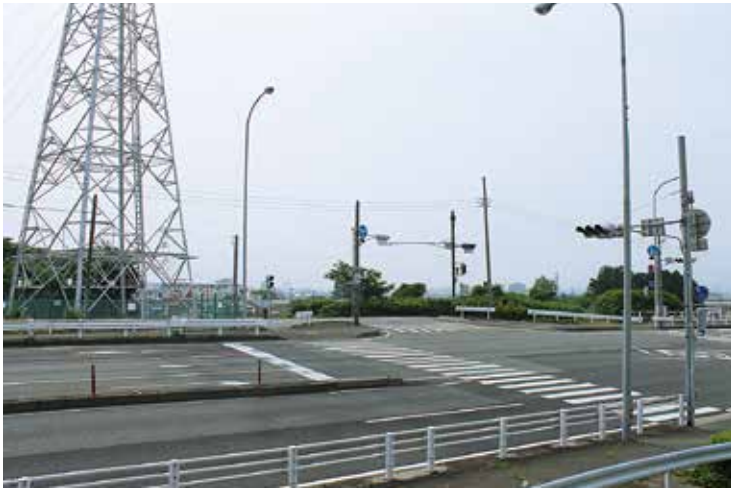
池田柵線が接続予定の陣場交差点
