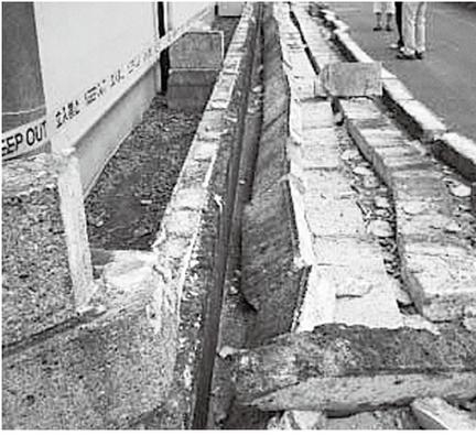
▲地震により倒壊したブロック塀
