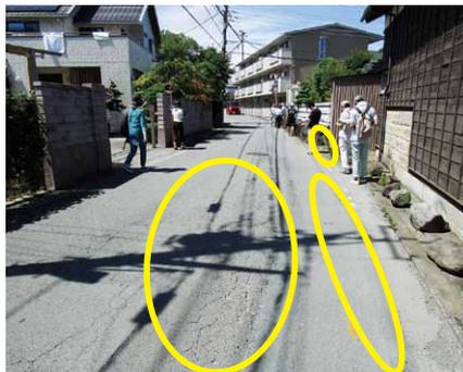
道路が劣化している。側溝がない。外側線が薄い。
