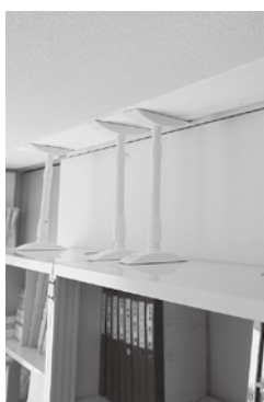
▲突っ張り棒を使用した棚の固定
