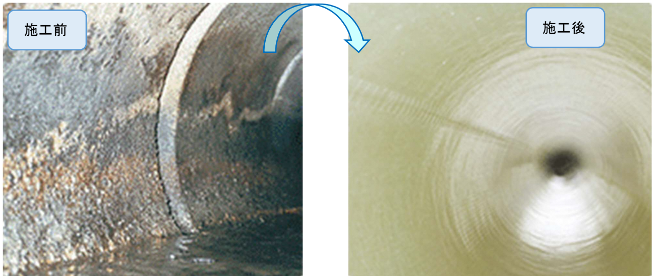
写真6-1 小口径管の管更生施工例
