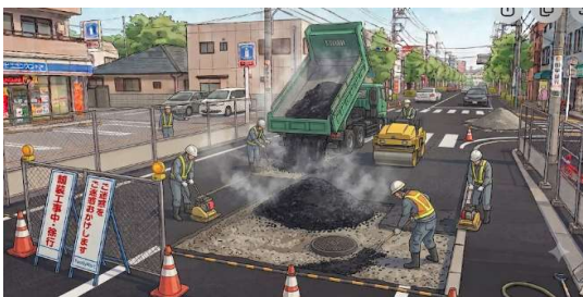
舗装施工状況
