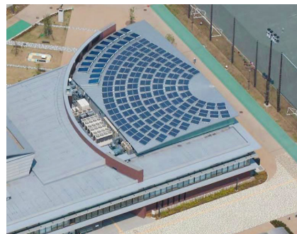
ウェルピアながいずみの 太陽光発電・太陽熱利用
