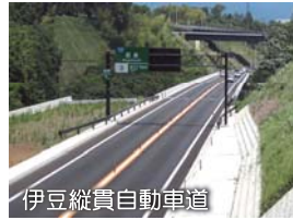
伊豆縦貫自動車道
