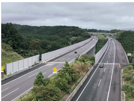
新東名高速道路の防音壁
