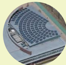
屋上の太陽光パネル
