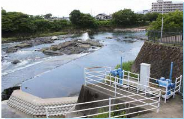
新井堰・黄瀬川取水口
