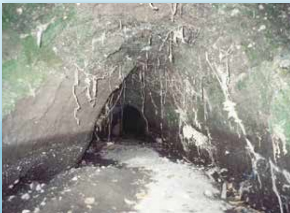
建設当時の素掘り隧道
