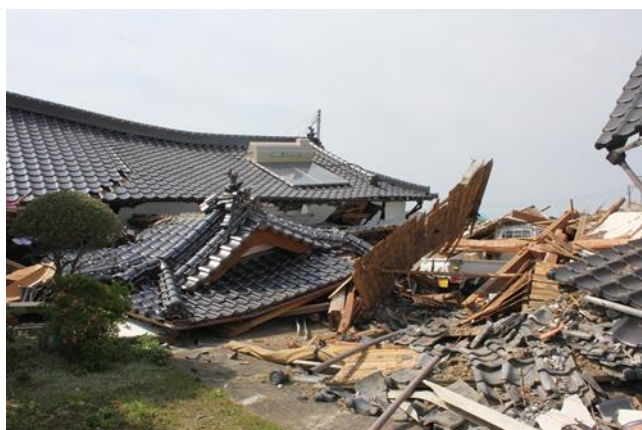
【H28. 4. 14 発生 熊本地震】 木造住宅の倒壊
