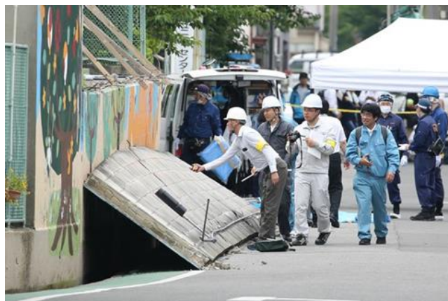
【H30.6.18 発生 大阪府北部地震】 ブロック塀の倒壊
