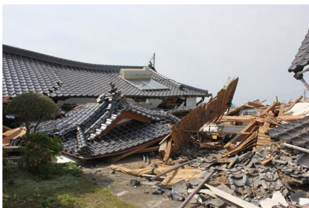
【H28.4.14 発生 熊本地震】 木造住宅の倒壊
