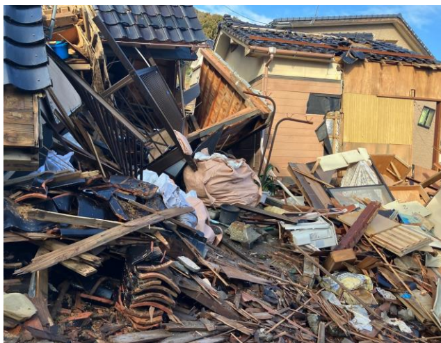
【R6.1.1 発生 能登半島地震】 木造住宅の倒壊
