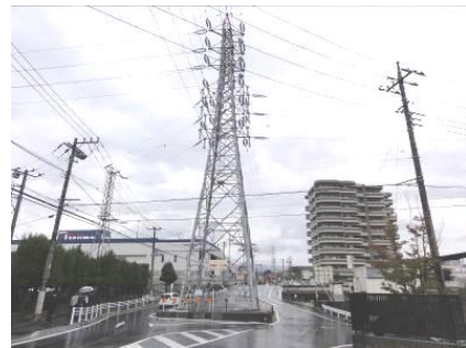
町道 252 号線上の鉄塔
