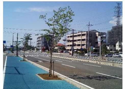
(都)池田柵線に植栽された街路樹
