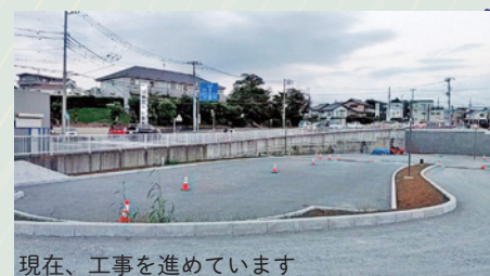
現在、工事を進めています
