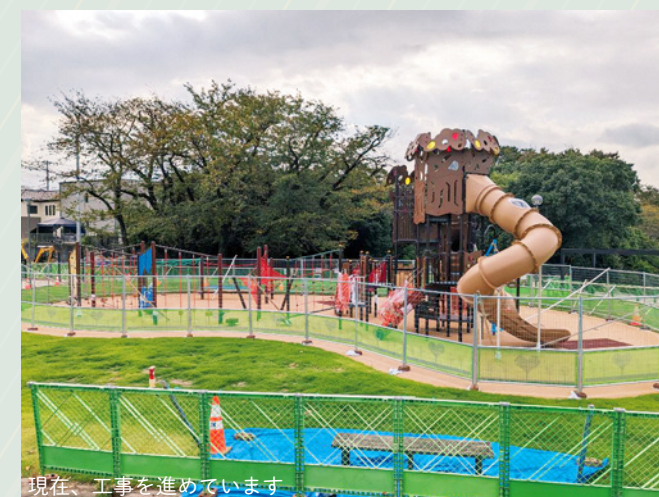
現在、工事を進めています
