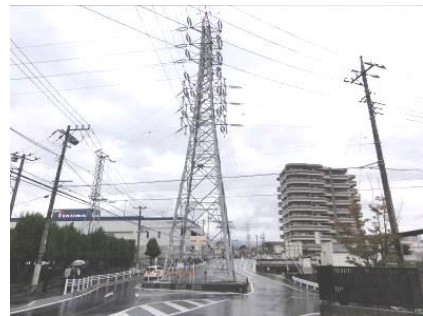
町道 252 号線上の鉄塔
