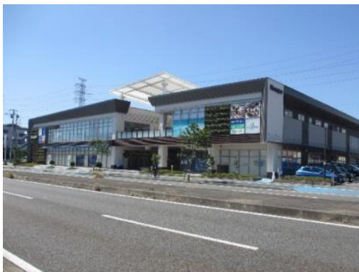
道路に面して開放的なしつらえの複合施設
