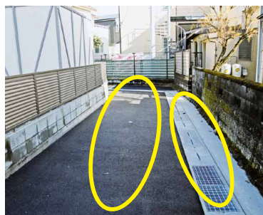
道路を舗装して側溝を設置し、誰もが通行しやすくなりました。
