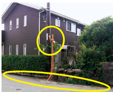
外側線・グリーンベルト・右側にカーブミラーがない。
