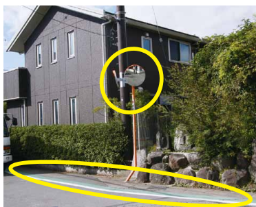
外側線とグリーンベルトを引き、歩行者の安全を確保し、左右のカーブミラーを設置し、見通しが良くなりました。
