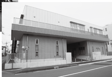
▲防災センター外観
