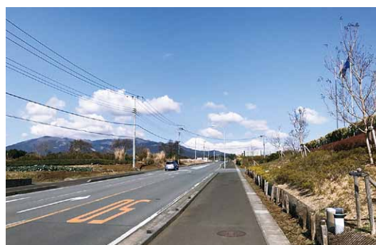
④町道 下長窪駿河平線 愛称「ファルマバレー通り」
