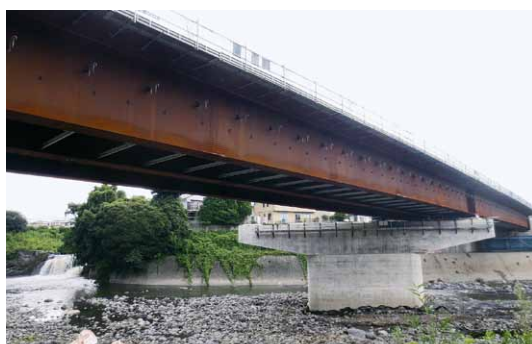
⑤都市計画道路池田柵線の桃沢川と 黄瀬川にかかる橋 愛称「鎧ヶ淵大橋」
