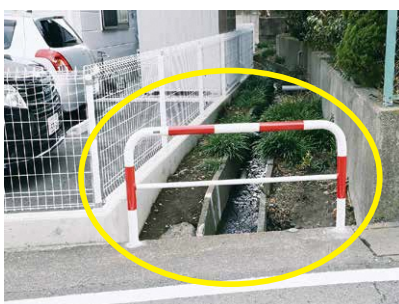
柵を設置した。
