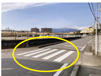
道路表示を引き直した。
