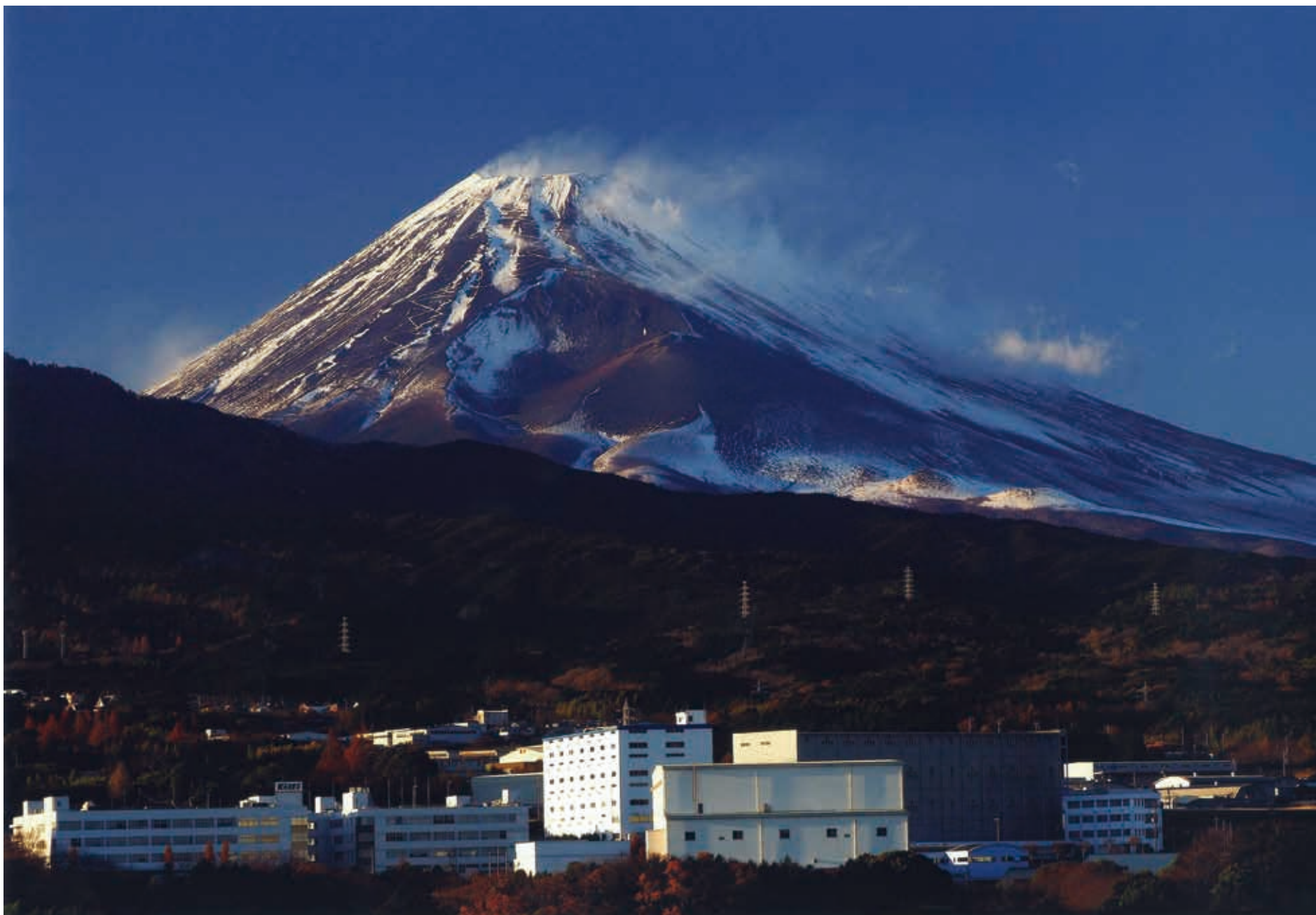
撮影地／長泉なめり駅付近
