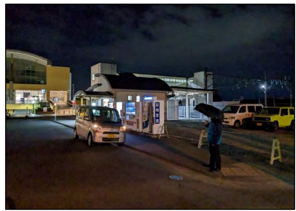
全体的に暗く、雨よげができるスペースが不足
