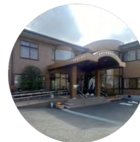
南部地区センター
