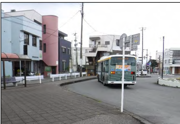
バスの横づけが困難、乗降位置に段差あり
