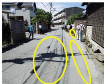
ビフォー 道路が劣化している。側溝がない。外側線が薄い。
