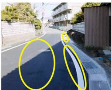
アフター 道路を舗装しました。また、側溝を新設し、外側線を引き直しました。
